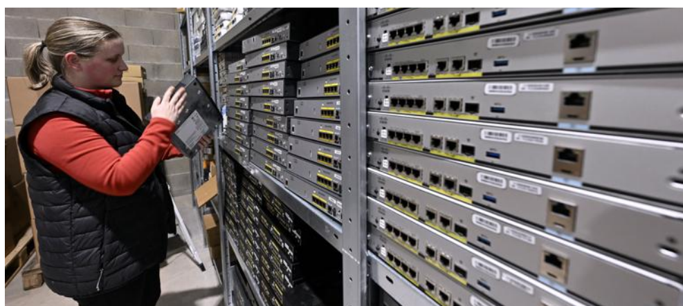
Adista est le premier opérateur télécoms alternatif français au service des entreprises et des collectivités en ce qui concerne le reconditionnement des routeurs. Photo Alexandre Marchi
