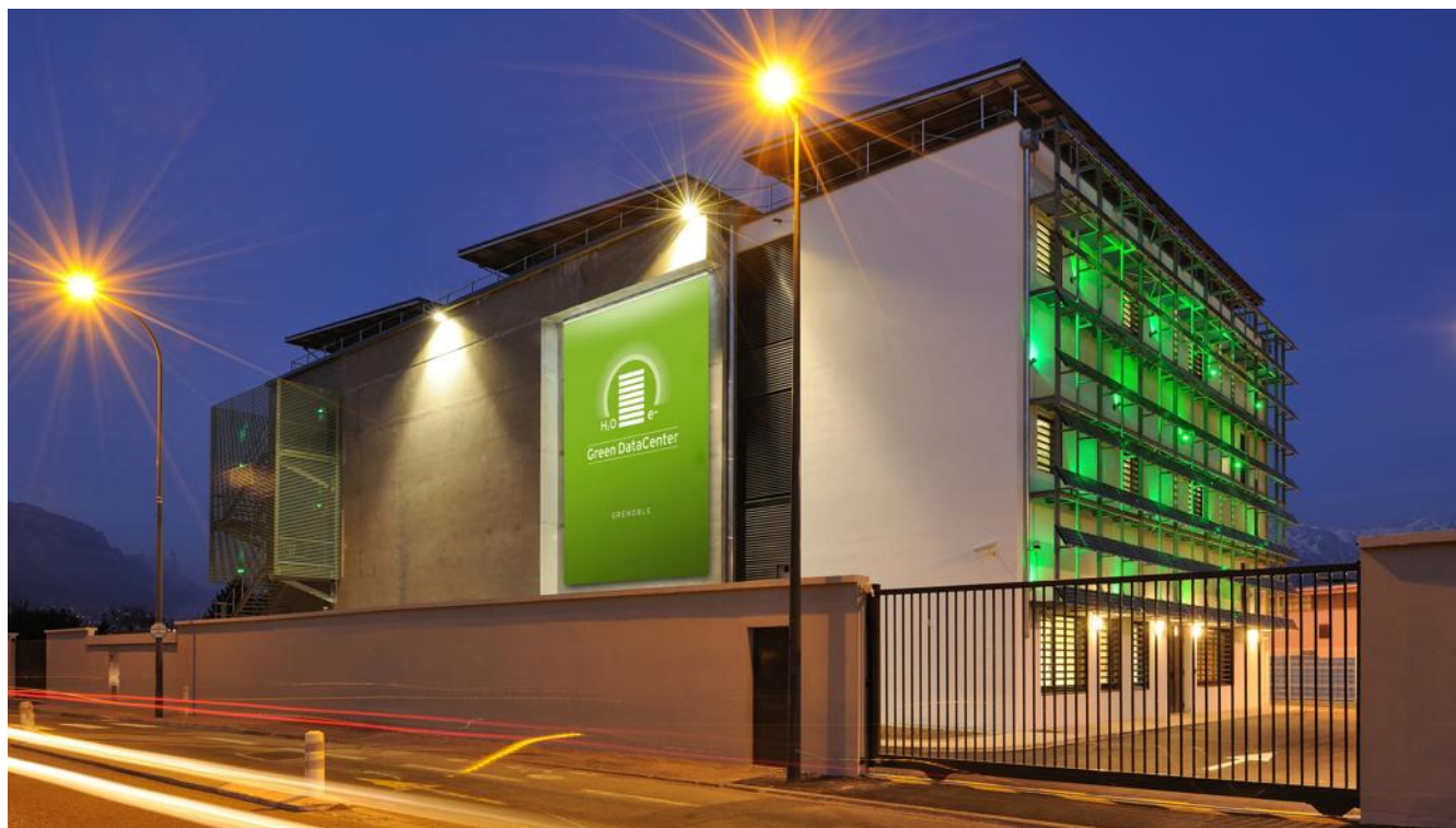
L'isolation du bâtiment et la température constante de la nappe phréatique font du data center grenoblois "une véritable glacière". Photo Erick Salliet
